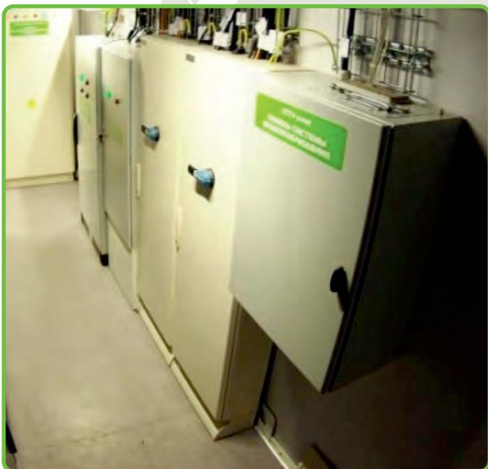
Система диспетчеризации обеспечивает получение и передачу необходимых параметров (в том числе информацию о потребления каждой стойки) от оборудования к оператору площадки. В случае возникновения неисправности инженерного оборудования, а также выхода климатических параметров внутри модуля за установленные пределы, информация о неисправности немедленно передается оператору площадки.
