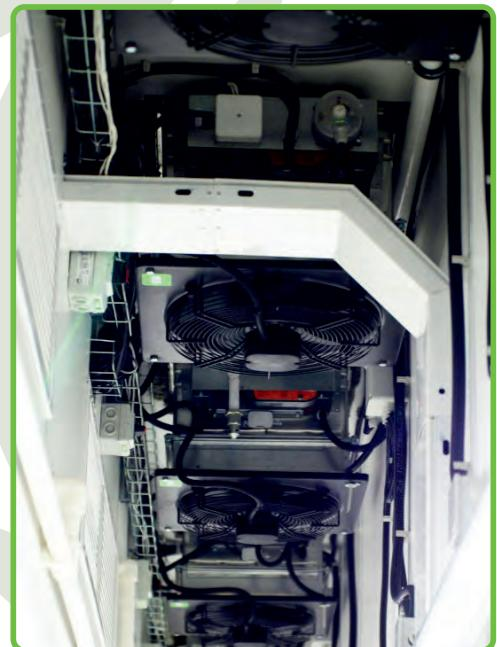
Приток воздуха в холодный коридор осуществляется при помощи 4-х приточных установок, со сменными фильтрами, степень отчистки воздуха F5 (стандарт для медицинских учреждений)
